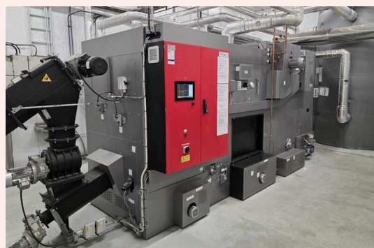
Den nya fastbränslepannan är nu i full drift.
